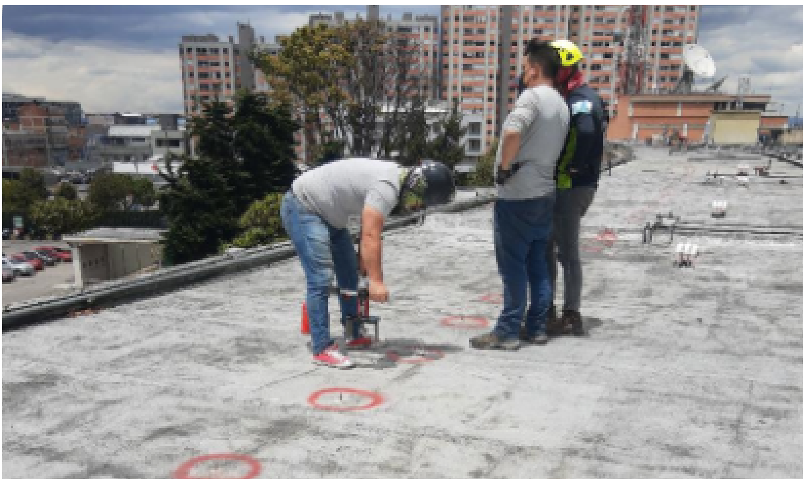
Impermeabilización techos Sede Bogotá
